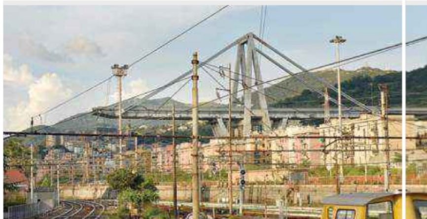
Il moncone di levante del Morandi come è oggi: i piloni e la carreggiata incombono sull'abitato
