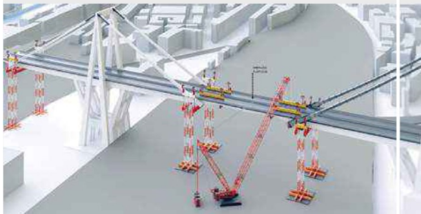
La simulazione dell'intervento delle gru al lavoro sull'impalcato a levante, con la carreggiata da smontare
