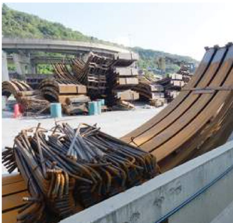
Il cantiere del nodo ferroviario genovese fermo da tempo
