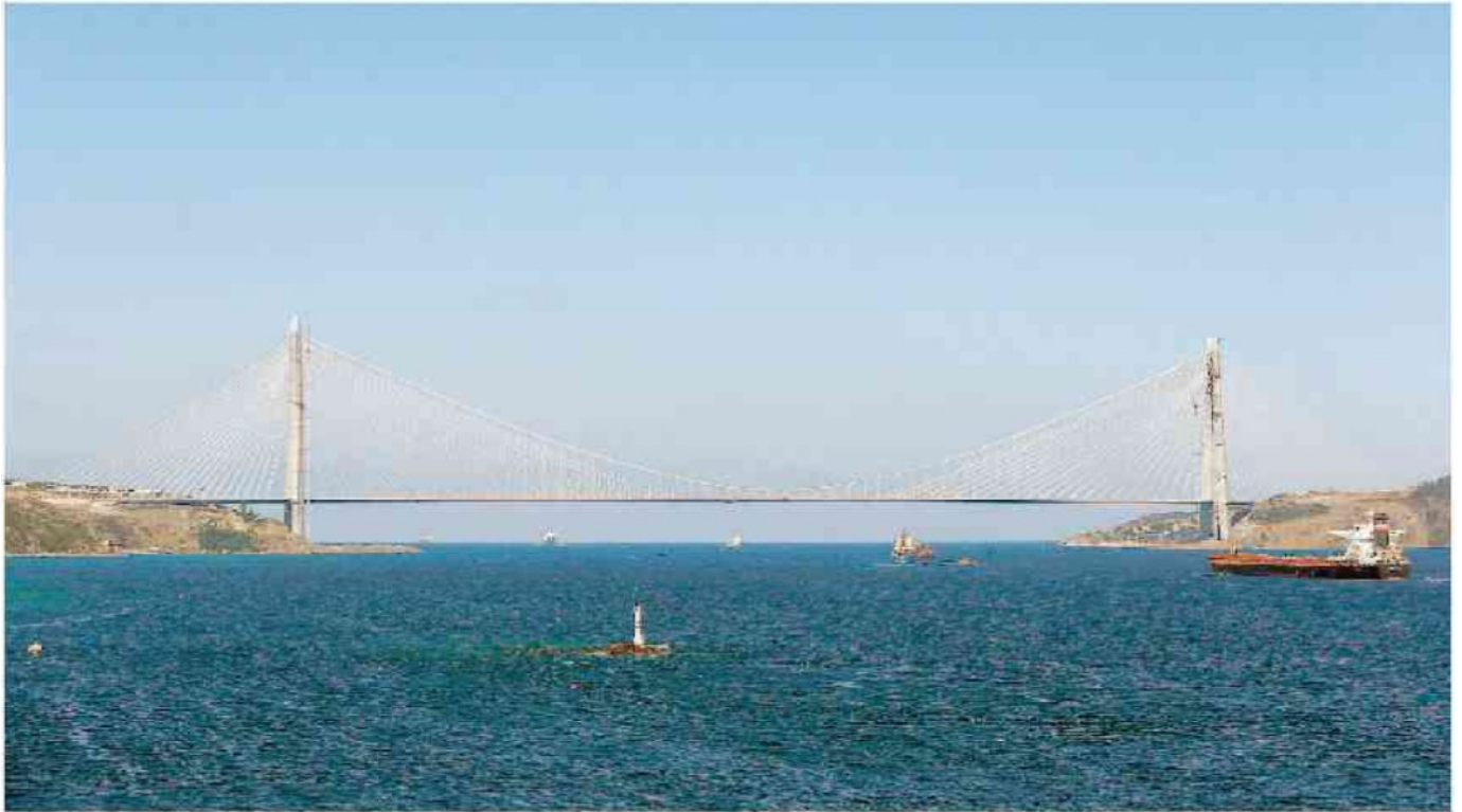
Una veduta generale del terzo ponte sul Bosforo
