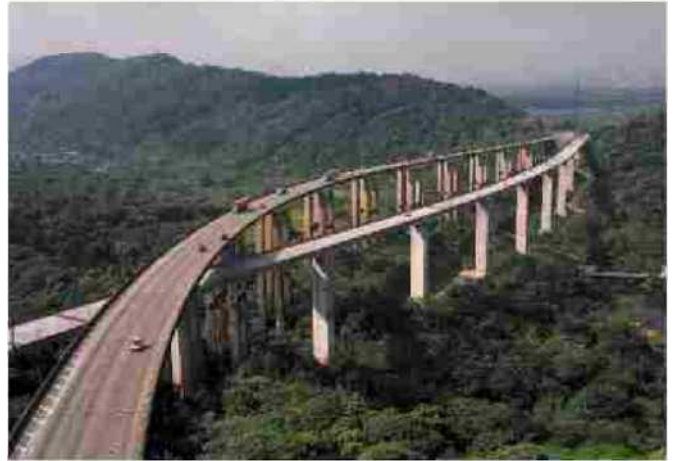
Un'autostrada realizzata da Salini Impregilo in Brasile
