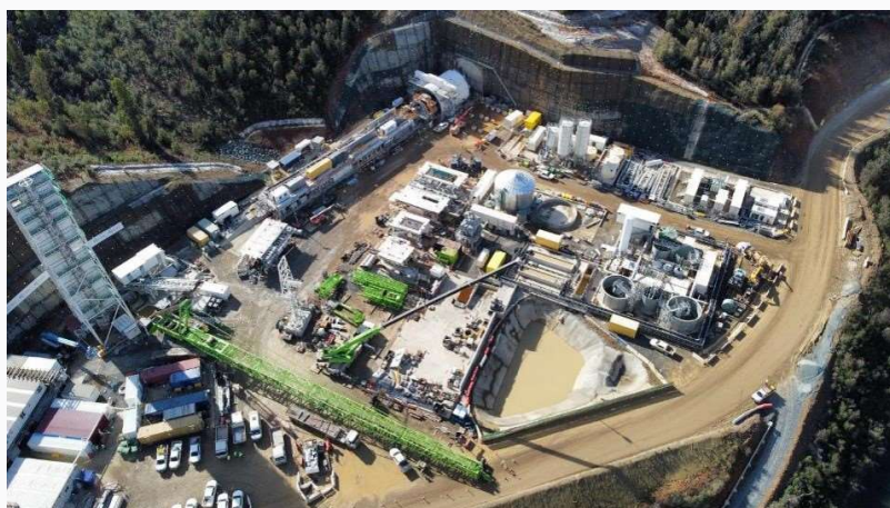
Vista dall'alto del cantiere del progetto Snowy 2.0
