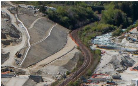
La superficie della scarpata, costituita da materiale particolarmente compatto, avrebbe potuto rappresentare un possibile piano di scivolamento dello strato di terreno vegetale da riportare. Tale condizione, in presenza di eventi piovosi eccezionali, avrebbe potuto inizialmente determinare l'innescò di fenomeni di distacco di porzioni di terreno in direzione della linea ferroviaria, con conseguenti rischi per l'esercizio della linea stessa.
