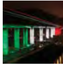
ITALIA Ponte Genova San Giorgio
