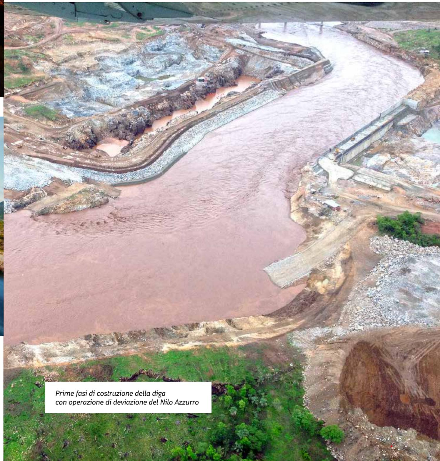
*Prime fasi di costruzione della diga con operazione di deviazione del Nilo Azzurro*
