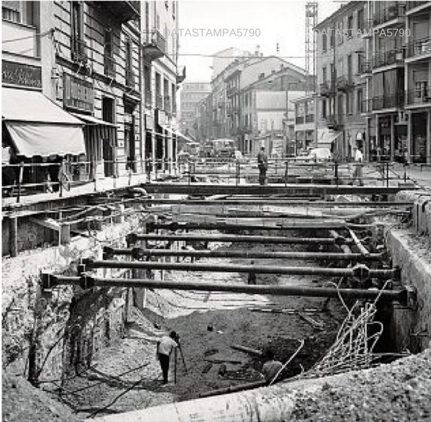
Milano Scavi per la costruzione della prima linea della Metropolitana negli anni Sessanta
